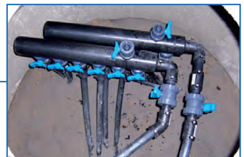
Montage der Verteiler-Balken im Beton-Schacht rechteckig oder rund
