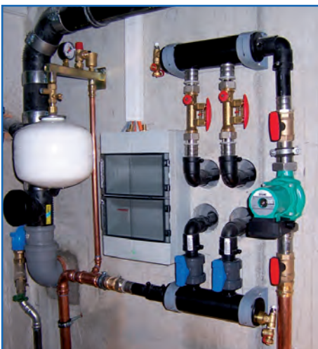
Verteiler im Technikraum montiert
