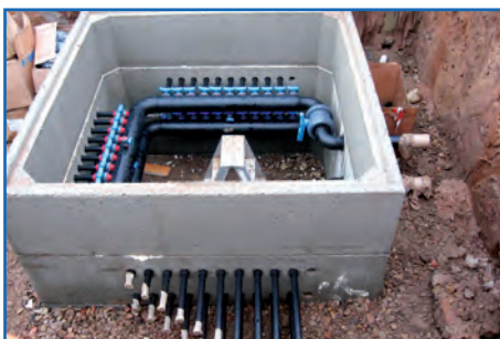
Montage der Verteiler-Balken im Beton-Schacht rechteckig oder rund
